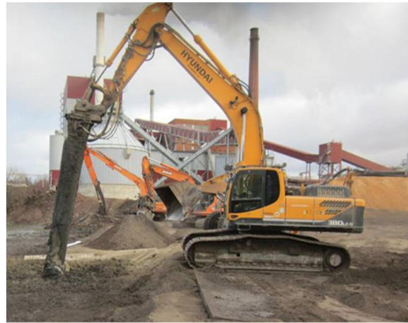
Kuva 3. Esisekoitus pitkäpuomisella kaivinkoneella. Kuva 4. Massastabilointi.
