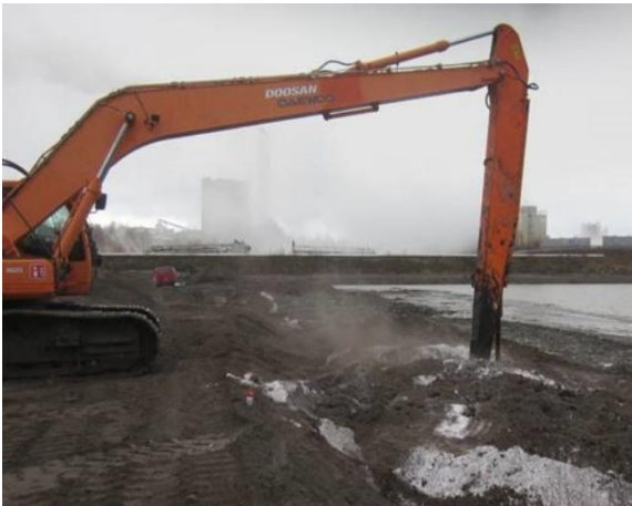
Kuva 3. Esisekoitus pitkäpuomisella kaivinkoneella. Kuva 4. Massastabilointi.
